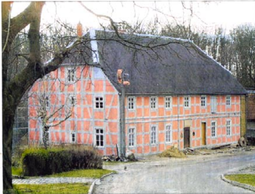
Zur Straße zeigt sich die Gollmitzer Wassermühle bereits verjüngt.
